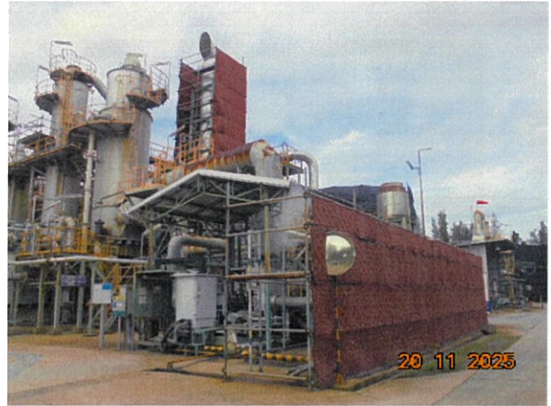
การติดตั้งแผ่นกันเสียงดังจากเครื่องจักร 4140-B1-T1
